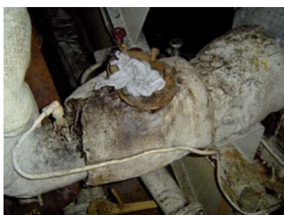
Figura A1.29 Detalle de calorifugado (textiles)
