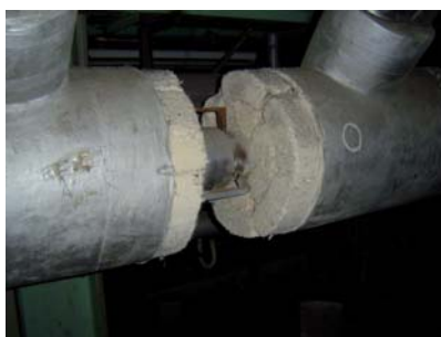
Figura A1.30 Detalle de calorifugado (coquilla)
