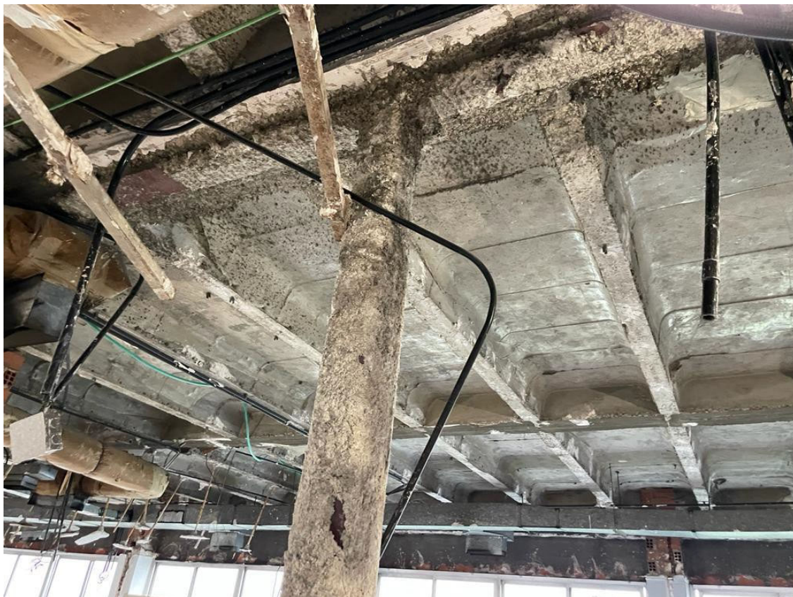
Imagende archivo proyectado amianto (mortero ignífugo)
